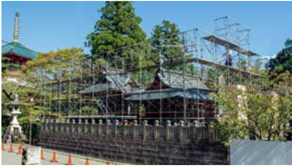
修復工事中の清瀧権現堂
