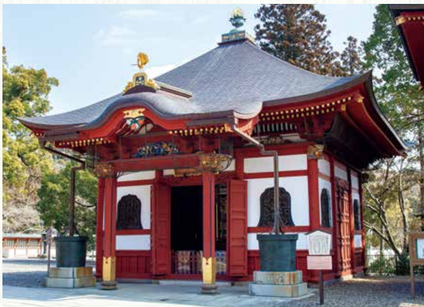
銅板葺き屋根で宝形造りの一切経堂（成田市指定文化財）
