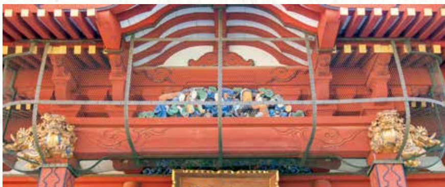
向拝柱間に架けられた水引虹梁。その上の連三ツ斗が軒桁を支えている
